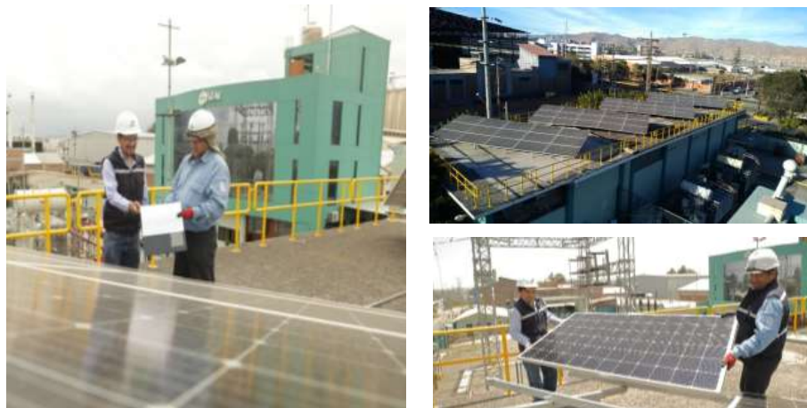
Implementación de Paneles fotovoltaicos
