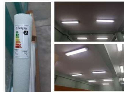
Cambio de Luminarias LED Sede Consuelo
